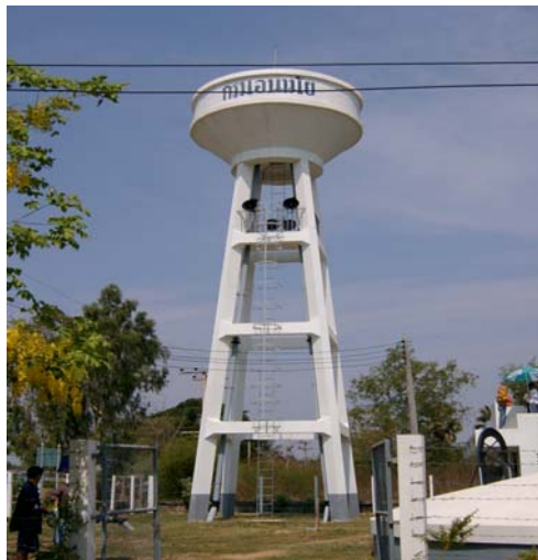
รูปที่ 22 หอถังสูง
